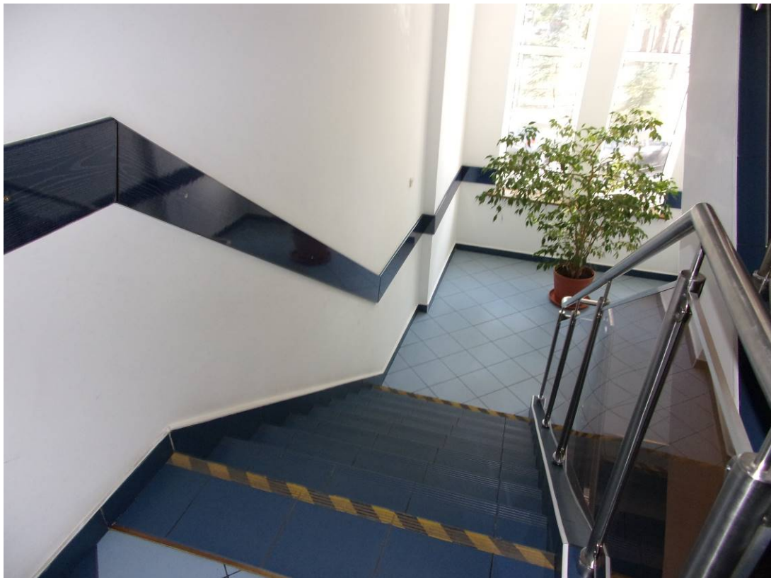
Fot. nr 3, 4: Klatki schodowe
